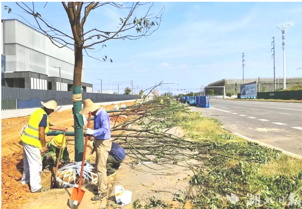
◇ 中建三局葛店片区项目种植和补植 6000 余株苗木
