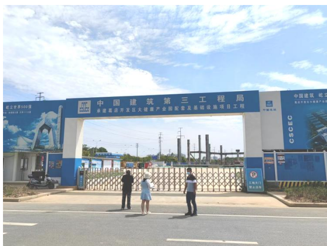
✧ 葛店开发区大健康产业园配套及基础设施项目检查（2022.10）
