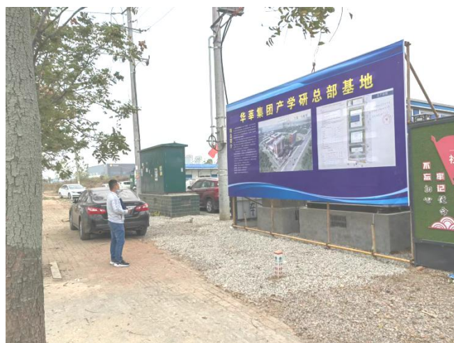
✧ 华莘集团产学研总部基地建设项目建设项目检查（2022.10）
